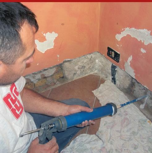
Agente impregnante con consistenza gelatinosa a base di silani per la formazione di barriere chimiche contro la risalita capillare di umidità, particolarmente adatto anche per nuove murature, anche alveolate (poroton, doppio uni, ecc.). Viene fornito in sacchetti rivestiti di alluminio da 600 cc (cartuccia "morbida"), da inserire nella apposita pistola dosatrice per sigillanti in sacchetti.
