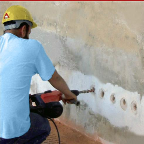
Sistema monocomponente a base di silani e silossani organo-modificati per la preparazione, con la sola aggiunta dell'acqua, di microemulsioni idrofobizzanti per iniezioni murarie attive contro la risalita di umidità capillare, specifiche per la realizzazione di barriere chimiche nelle murature in mattoni, tufo, pietra e miste, di vario spessore.
