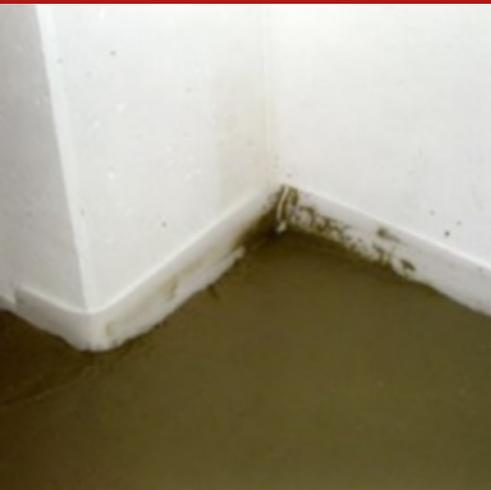
Floorband 200, realizzato in polietilene a celle chiuse di 20 cm di altezza, leggero, impermeabile, imputrescibile, inattaccabile da muffe e con un'elevata resistenza alle aggressioni chimiche ed alle reazioni alcaline dei manufatti cementizi, viene utilizzato prevalentemente come fascia isolante perimetrale, durante la costruzione di massetti e/o pavimenti in calcestruzzo.
