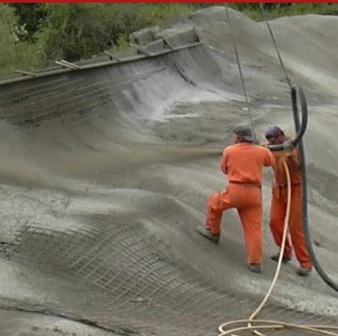
Soluzione di reattivi minerali, priva di alcali (alcali-free), da utilizzare per l'accelerazione di presa di betoncini spruzzati e calcestruzzi proiettati, nel consolidamento di rocce all'aperto e/o in galleria, nella costruzione di rivestimenti autosostentanti ed impermeabilizzanti di gallerie, canali, volte, bacini, opere sotterranee, ecc., da utilizzare sia a secco che a umido direttamente nel mix design del calcestruzzo da spruzzare.
