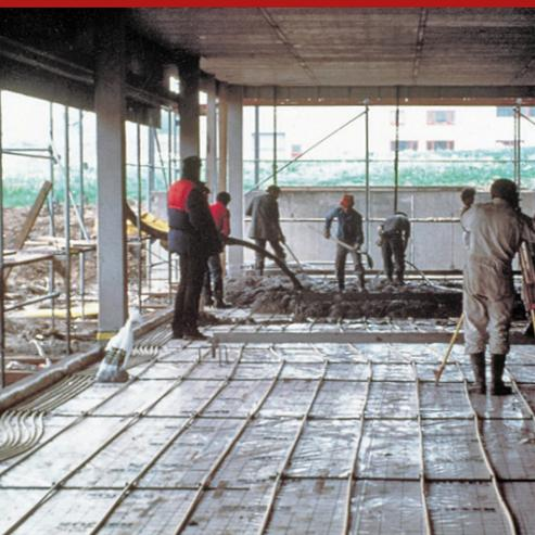
Additivo polivalente in soluzione specifico per il miglioramento della conducibilità termica dei conglomerati cementizi, attraverso equilibrate azioni di tipo superlubrificante, disareante, plastificante. Fluid Therm è perfettamente compatibile in abbinamento con fibre in acciaio Readymesh MM-150 (solitamente dosate a 25 kg/m<sup>3</sup>) o fibre in polipropilene multifilamento Readymesh PM-180 (solitamente dosate a 1 kg/m<sup>3</sup>).
