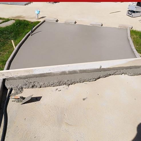
Premiscelato in polvere per il confezionamento di calcestruzzi impiegati per la realizzazione di pavimentazioni architettoniche di valenza paesaggistica/ambientale, con la tecnica del "ghiaietto lavato o ghiaia a vista". Prerit Mix Plus additivato solamente con l'inerte scelto e l'acqua di impasto necessaria è pronto per essere mescolato e posato per realizzare pavimentazioni architettoniche.
