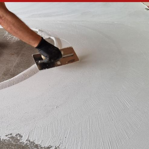
Prodotto in polvere a base di speciali leganti idraulici, inerti selezionati e additivi polimerici adesivi per la rasatura di calcestruzzo e superfici poco assorbenti come piastrelle in ceramica e klinker per regolarizzare i supporti prima di cicli resinosi decorativi.
