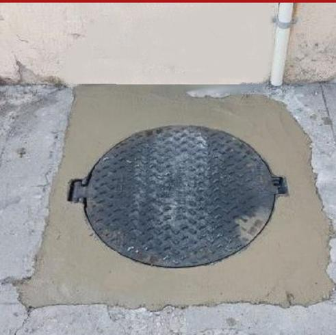
Malta strutturale tixotropica, fibrorinforzata con microfibre d'acciaio, a rapido indurimento, a base di cementi portland, leganti speciali, aggregati silicei selezionati ed agenti specifici di reologia, per riparazioni, ricostruzioni ed ancoraggi caratterizzati da un rapido sviluppo di resistenze meccaniche anche a basse temperature.
