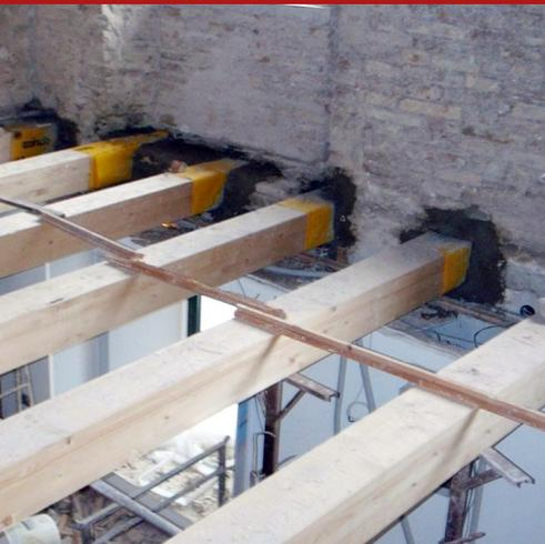
Malta tixotropica, fibrorinforzata, antiritiro e leggermente espansiva in fase plastica, ad elevate prestazioni in termini di resistenza caratteristica e impermeabilità, specifica per la compensazione delle cavità e dei distacchi nelle sottomurazioni a rinzaffo, per la sigillatura ed il rinforzo delle fughe nelle murature, e per il fissaggio di precisione di travi in legno o acciaio in murature di qualsiasi natura.
