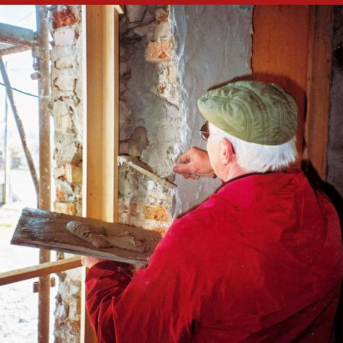
Composto adesivo, tixotropico, a base di calce idraulica, fibrorinforzato, a rapido indurimento, per il fissaggio e l'ancoraggio, nei corpi murari, di strutture, inserti, piastre, telai, barre, sanitari ecc., negli interventi bioedili, nelle nuove costruzioni e nel restauro di edifici d'epoca e monumentali.
