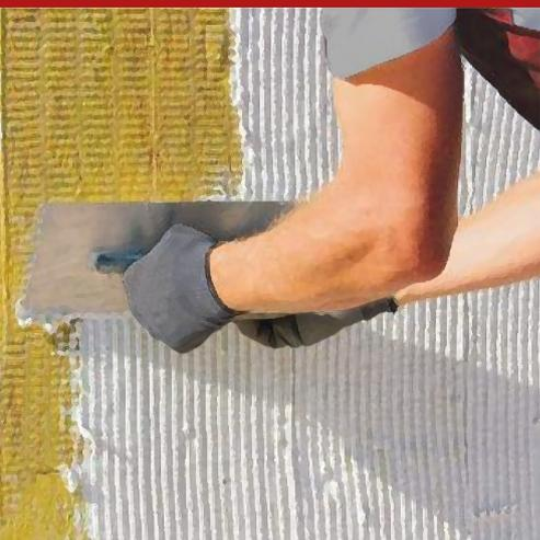
Collante-rasante monocomponente a base di calce idraulica, speciali polimeri flessibili, additivi reologici, ritentori d'acqua, microsilicati ad attività pozzolanica, aggregati sferici a basso peso specifico. Da utilizzarsi per rasature di regolarizzazione su svariati supporti, incollaggi leggeri e come rasante/collante della nostra speciale membrana SANATEX (su ponti termici, murature umide e/o lesionate).
