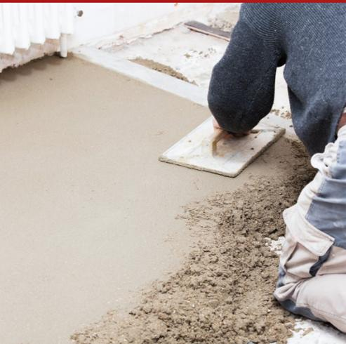
Massetto pedonabile, per interno ed esterno, a base di calce idraulica, inerti silico-calcarei con granulometria massima 5 mm e inerti leggeri ad attività pozzolanica, cocciopesto in granulometria 0-2 mm, fibrorinforzato con microfibre di polipropilene e vetro, utilizzato per la costruzione, con la sola aggiunta dell'acqua, di massetti e sottofondi resistenti, negli interventi bioedili e nel restauro di edifici d'epoca e monumentali.
