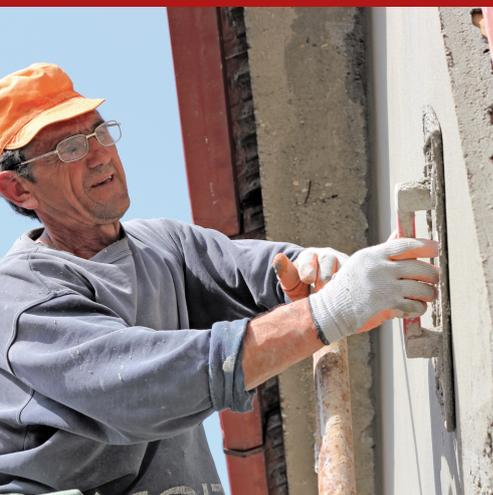
Intonaco macroporoso, fibrorinforzato, a base di calce idraulica naturale NHL 3,5, per la deumidificazione ed il risanamento igrometrico di edifici e murature, negli interventi bioedili, nelle nuove costruzioni e nel restauro di edifici d'epoca e monumentali.
