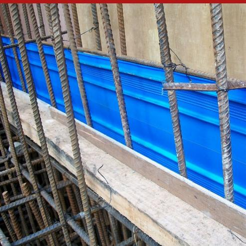
Il waterstop SEALPVC SF 200 è un profilato impermeabile in PVC non idroespansivo, di larghezza 20 cm e dotato di elevata elasticità. Viene impiegato nei giunti statici per ripresa di getto orizzontali (solettoni), nelle strutture in calcestruzzo, appoggiato al sottofondo sotto l'armatura.
