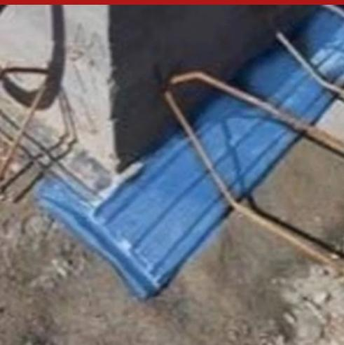
Il waterstop SEALPVC SF 250 è un profilato impermeabile in PVC non idroespansivo, di larghezza 25 cm e dotato di elevata elasticità. Viene impiegato nei giunti statici per ripresa di getto orizzontali (solettoni), nelle strutture in calcestruzzo, appoggiato al sottofondo sotto l'armatura.
