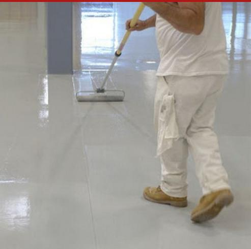
Rivestimento elastomerico poliuretano alifatico bicomponente, UV resistente, colorato, in veicolo solvente, utilizzabile per la finitura lucida di superfici in calcestruzzo, sistemi impermeabilizzanti, vetroresina, metallo e supporti soggetti a movimenti e sollecitazioni fisiche.
