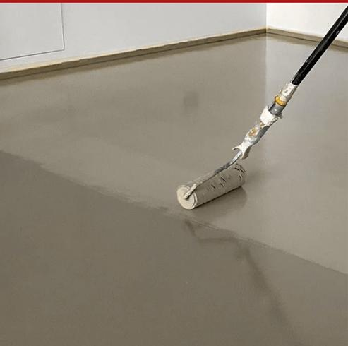
Rivestimento monocomponente a base di resine poliuretaniche, per il rivestimento, l'impermeabilizzazione e la protezione elastica di tetti, terrazze, scale, ponti e superfici crepate o soggette a microfessurazione e cavillature. Utilizzabile anche come impermeabilizzante sotto piastrella.
