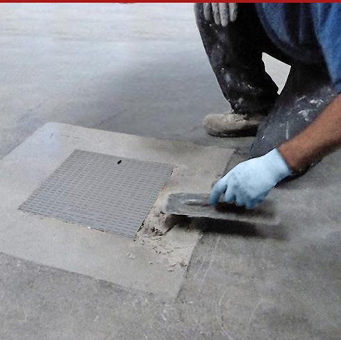
Syntech Grout EP è una malta epossidica fluida senza solventi costituita da resine epossidiche, additivi specifici e aggregati selezionati di varia granulometria per interventi di ripristino su strutture in cemento armato, pavimentazioni in calcestruzzo, realizzazione di giunti rigidi, ancoraggi ad alta resistenza, inghisaggi di barre. Si applica facilmente per semplice colatura realizzando fino a 5 mm di spessore per strato.
