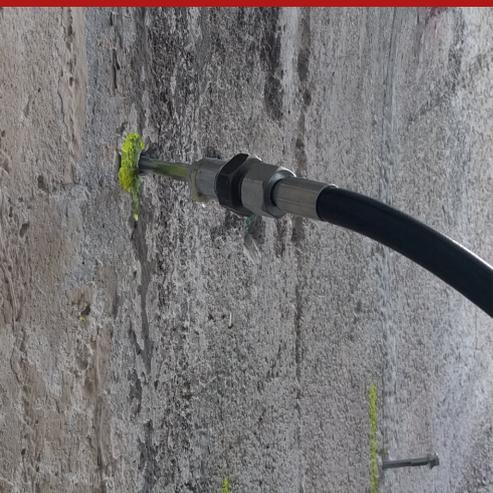
Elemento di connessione tra gli iniettori a testa piatta e il tubo pompante di pompe manuali o elettriche, utilizzate per bloccare le infiltrazioni d'acqua mediante iniezioni di resine poliuretaniche idroreattive.
