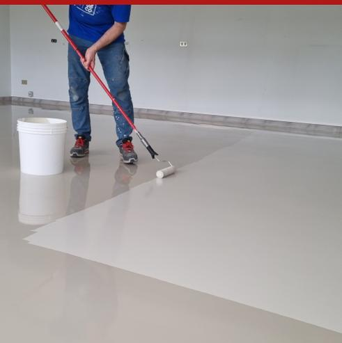
Rivestimento epossidico bicomponente, colorato, in dispersione acquosa per la finitura lucida di superfici in calcestruzzo e sottofondi cementizi.
