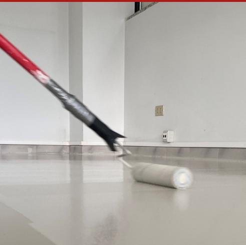
Finitura protettiva traspirante acril-uretanica alifatica, monocomponente, UV resistente, colorata in dispersione acquosa per la finitura satinata di superfici diverse. Il prodotto è un sistema di verniciatura idoneo per ambienti con presenza di alimenti, utilizzabile per proteggere pareti e soffitti che rispettano il protocollo HACCP, al fine di prevenire possibili contaminazioni degli alimenti.
