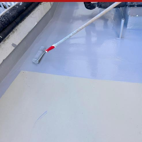
Rivestimento poliuretano alifatico bicomponente, resistente ai raggi UV, colorato, in veicolo a solvente, per la finitura lucida di superfici in cemento, vetroresina e acciaio.
