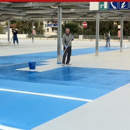
Rivestimento protettivo, pigmentato, bicomponente, a base di resine poliuretatiche alifatiche, ideale per la finitura protettiva ed estetica di impermeabilizzazioni eseguite con SYNTECH POLIUREA SPRAY. Caratterizzato da elevati livelli di elasticità e protezione, anche in presenza di atmosfere aggressive e severi ambienti d'esposizione. Disponibile a richiesta nelle gradazioni della gamma colori RAL.
