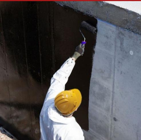
Rivestimento bicomponente a base di resine epossidiche e bitumi modificati per il rivestimento ad alto spessore con protezione antiacido di vasche di depurazione, serbatoi, vasche di recupero in calcestruzzo e acciaio.
